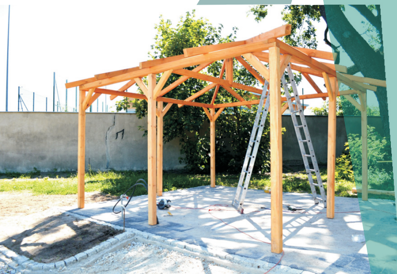
Budowa altanki ogrodowej
