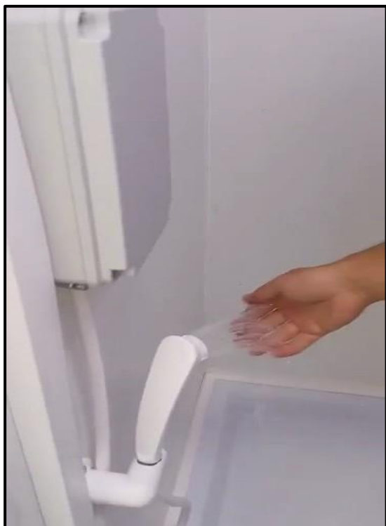
Fotografia nr 26. Uruchamianie wody w prysznicu,
