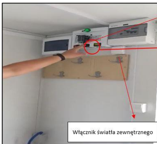
Fotografia nr 23. Budowa i funkcje rozdzielnicy.
